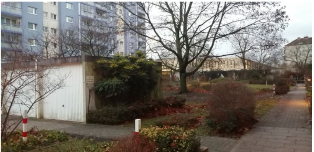
Foto: Im Bebauungsplan heißt es: „Holzmindener Straße 24 ist ein eingeschossiger Selbstbedienungsladen der GVG errichtet worden...“. Weg ist er.
